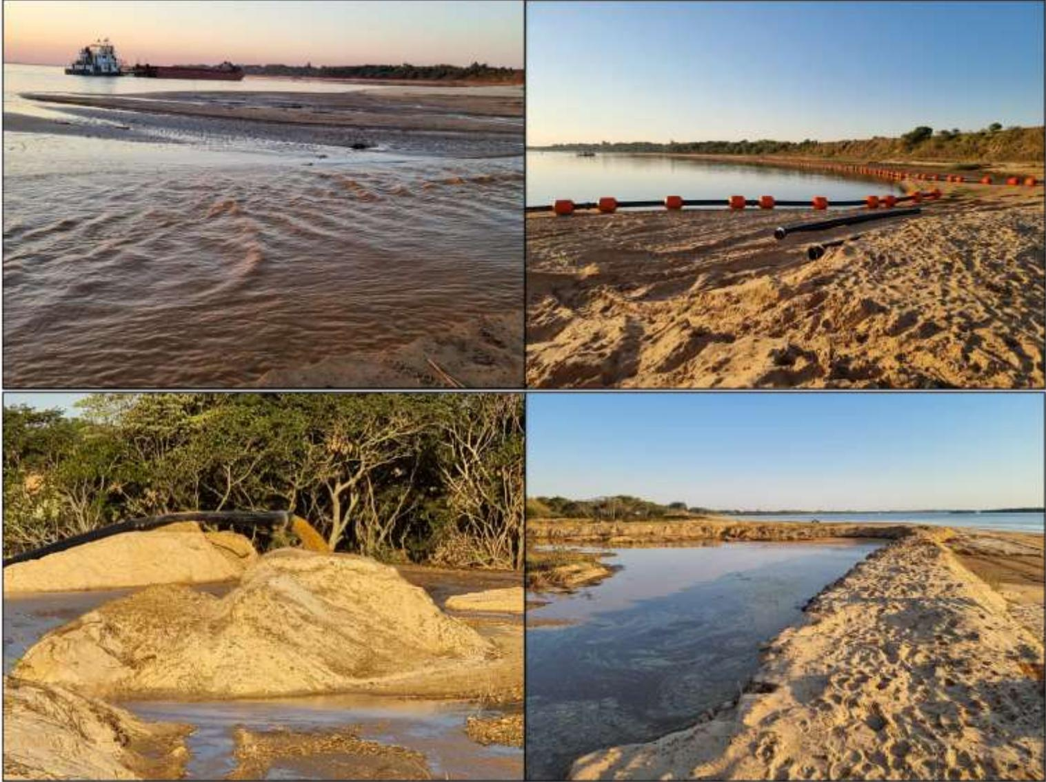
Observación del funcionamiento de la draga durante la remoción de arena y posterior vertido en la pileta de decantación de la playa de Ituzaingó.
